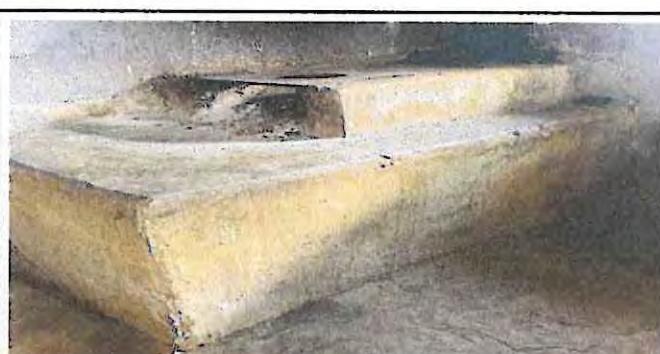
Foto 6: Implementación de azulejo en la cocina
