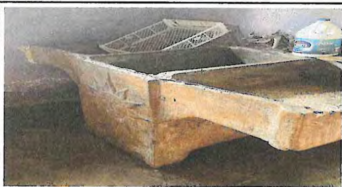
Foto 3: Sustitución de pila
