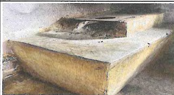
Foto 2: Reparación de estufa rural
